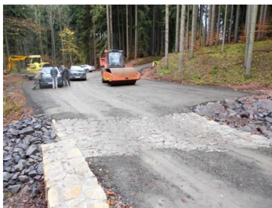
Příklad řešení záhozu na odvodnění skrz pěšiny
